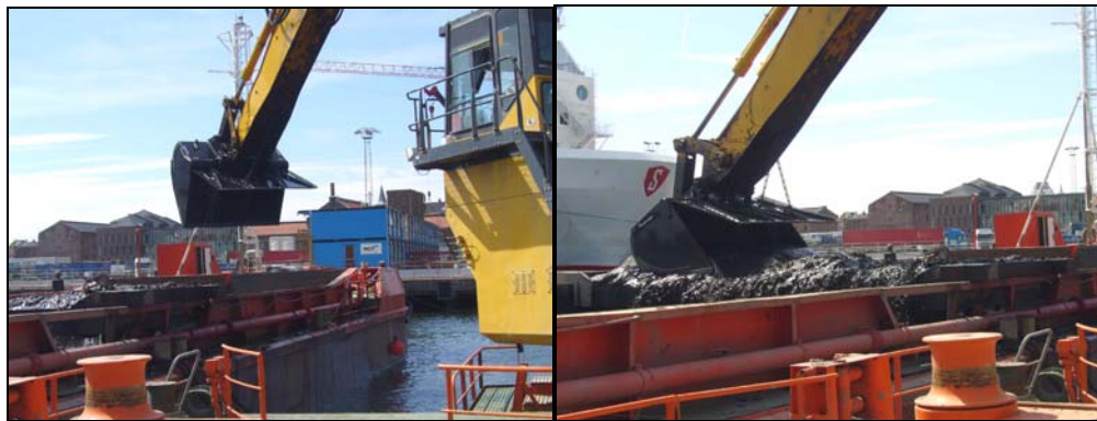
Figur 2: Foto av lasting av mudrede masser over i transportleker. Massene føres gjennom en rist slik at eventuelle arkeologiske objekter blir avdekket. Graveskuffen er påmontert et lokk som hindrer spredning av masser når skuffen løftes opp til overflaten.
