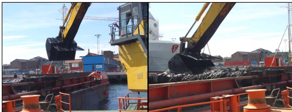
Figur 1. Foto av fra Secoras mudring i Bjørvika. Bildet viser den tilpassede graveskuffen med lokk utviklet for å minimere spredning av forurenset masse.
