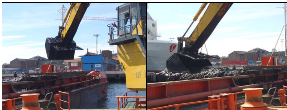
Figur 2 Foto av lasting av mudrede masser over i transportlekter
