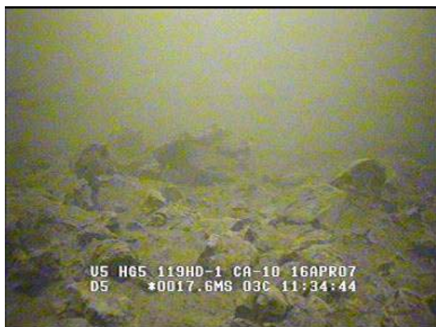
Bilde 4: Undervannsvideo (ROV) viser at man lykkes med å skjære opp leiren, slik at man får en jevn tykkelse på laget på sjøbunnen. Foto: NGI.
