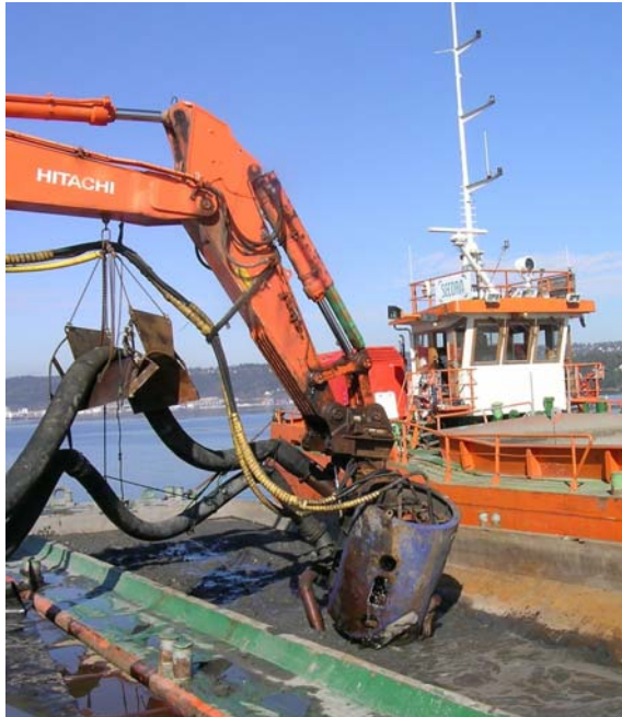
Bilde 7: Masser fra Paddehavet pumpes ned i deponiet. Foto: Elin Sæther, HAV.
