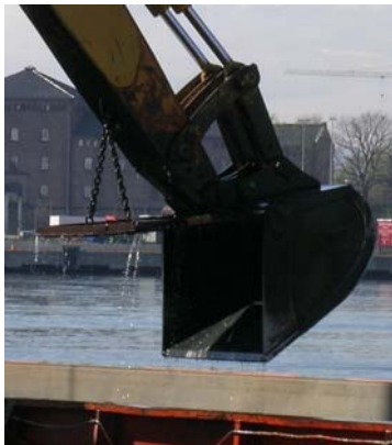
Bilde 3: Mudringen foregår med graveskuffe påmontert lokk. Foto: Elin Sæther, HAV
