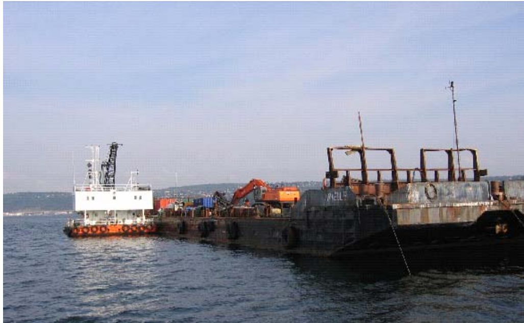
Figur 3 Lekter ved dypvannsdeponiet ligger klar for nedføring av masser.
