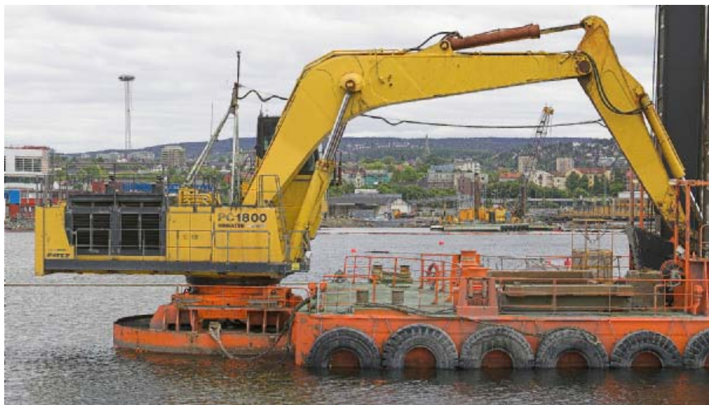
Figur 1 Foto av Secoras mudringsfartøy
