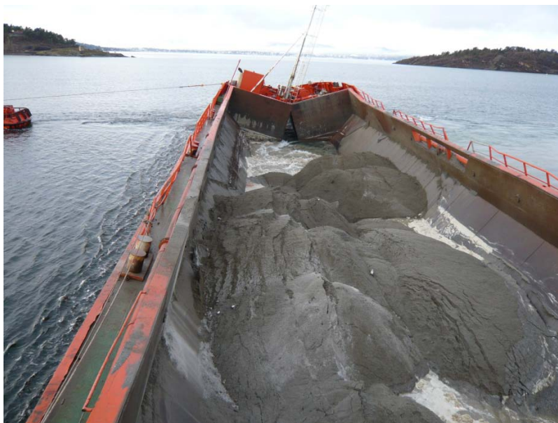
Figur 1 Bilde av utlegging av tildekkingsmaterialet ved hjelp av splittlekter under prøvetildekking.
