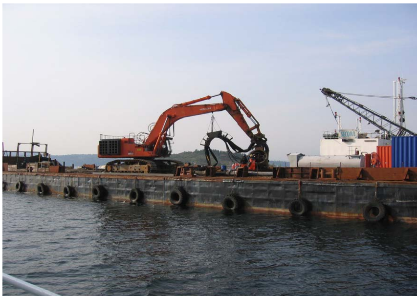
Figur 3 Foto av nedføringsenheten som viser gravemaskinen påmontert pumpe som senkes ned i transportlekkerens lasterom slik at massene suges opp og nedføres til deponiet via nedføringsrør med 50 cm diameter
