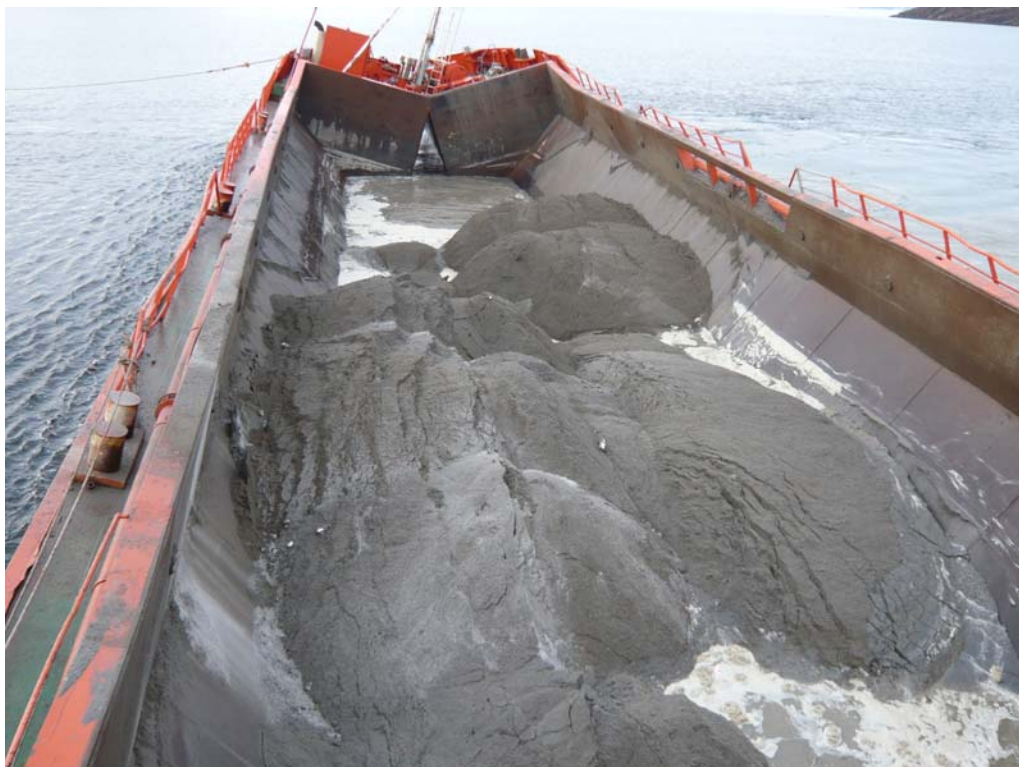
Figur 5 Massene legges ut mens fartøyets hastighet er 1-2 knop.
