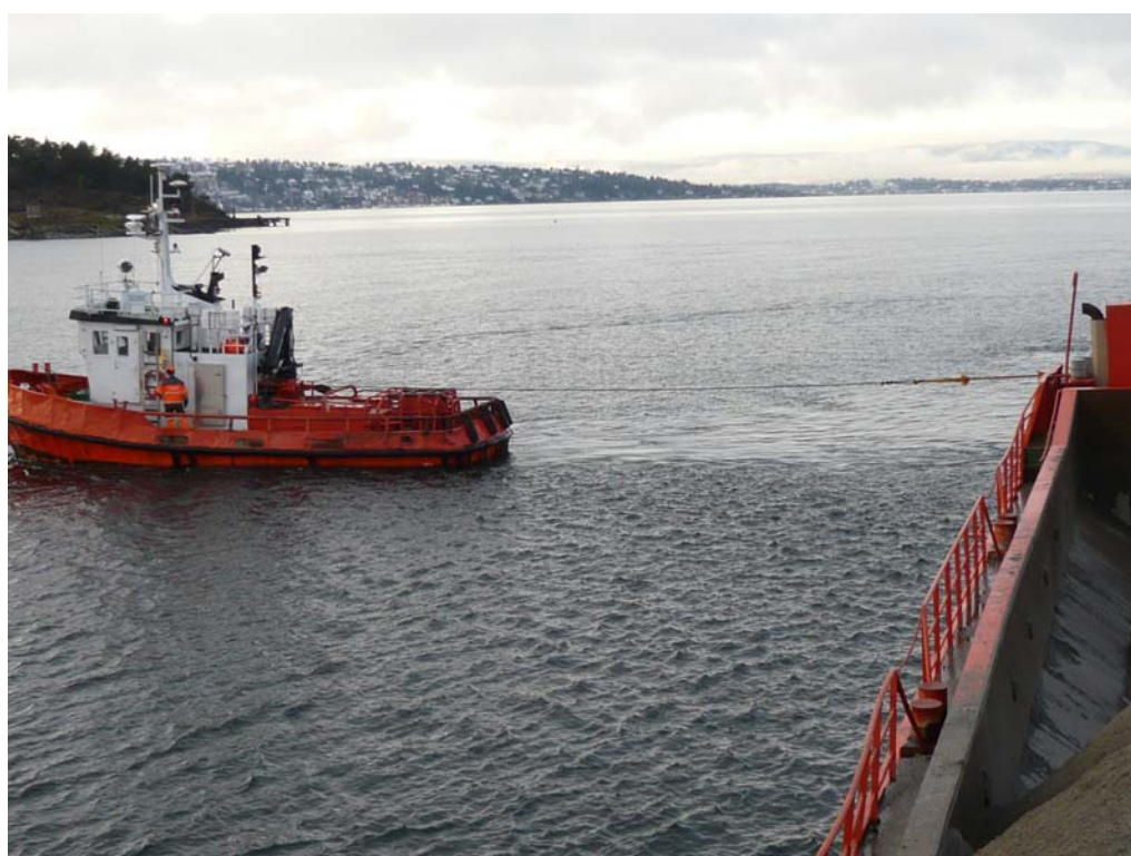
Figur 4 Massene legges ut fra splittlekteren mens den trekkes sidelengs assistert av slepebåt. Senere er lekterens baugtrustere benyttet.
