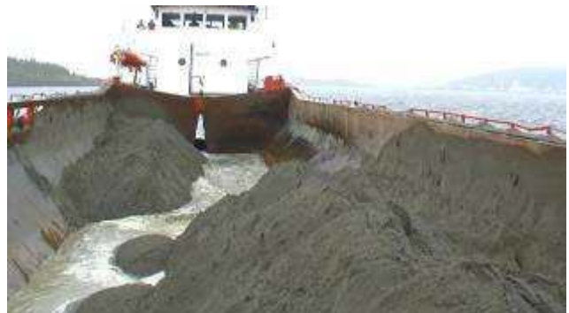
Figur 1-1. Splittlekter med rene masser tømmes over deponiet.
