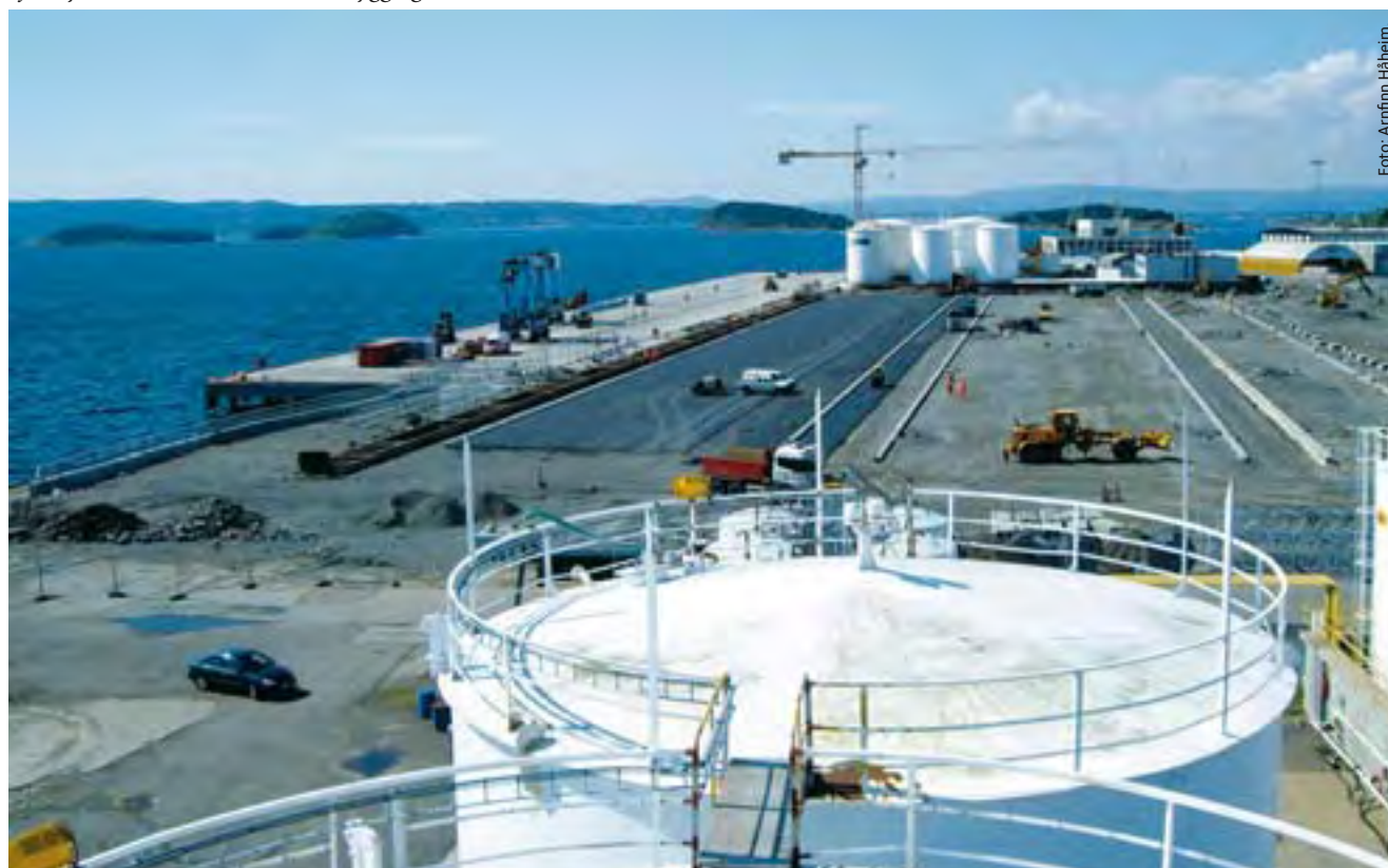
Sjørsøya containerterminal under bygging
