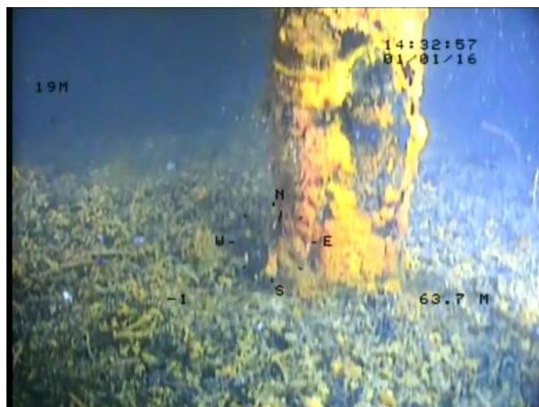
Sandlaget er målt til 25 cm i felt. Dybdeindikatoren viser 63,7 m. En halv meter mindre enn kontrollen i 2009. Dette kan henge sammen med tidevann.
