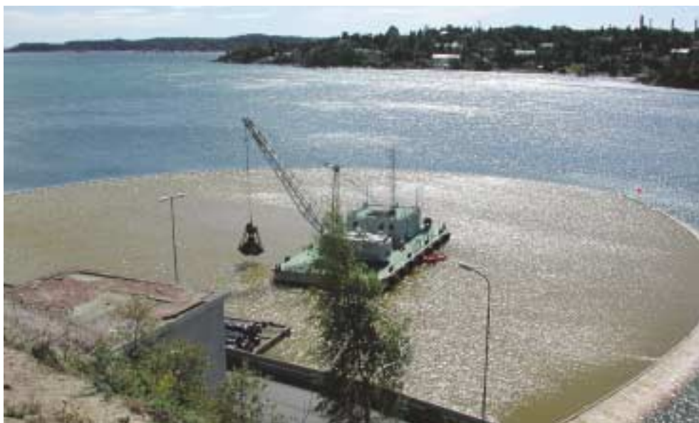
Fig. 3. Bildet viser betydningen av å bruke siltskjørt ("lense") rundt mudringsfartøyet. (Foto: Jon Egil Vinje, Fylkesmannen i Vest Agder)
